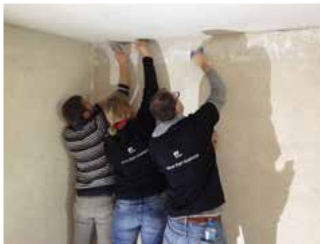
EY Mitarbeitende bei der Sanierung eines Bauernhauses, Mollis (GL)
